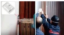
Paso 3 / Step 3 / Étape 3 Fijar el panel a la pared a su vez con clips. Fix the panel to the wall in turn with clips. Fixer le panneau au mur à son tour à l'aide de clips.
