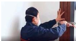
Paso 2 / Step 2 / Étape 2 Pegar el panel a la pared y fijar con clavos. Glue the panel to the wall and fix with nails. Coller le panneau au mur et le fixer avec des clous.
