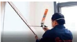
Paso 1 / Step 1 / Étape 1 Cortar el panel a la longitud apropiada y aplicar espuma de poliestireno en la parte posterior. Cut the panel to the appropriate length and apply styrofoam to the back. Couper le panneau à la longueur appropriée et appliquer de la mousse de polystyrène à l'arrière du panneau.
